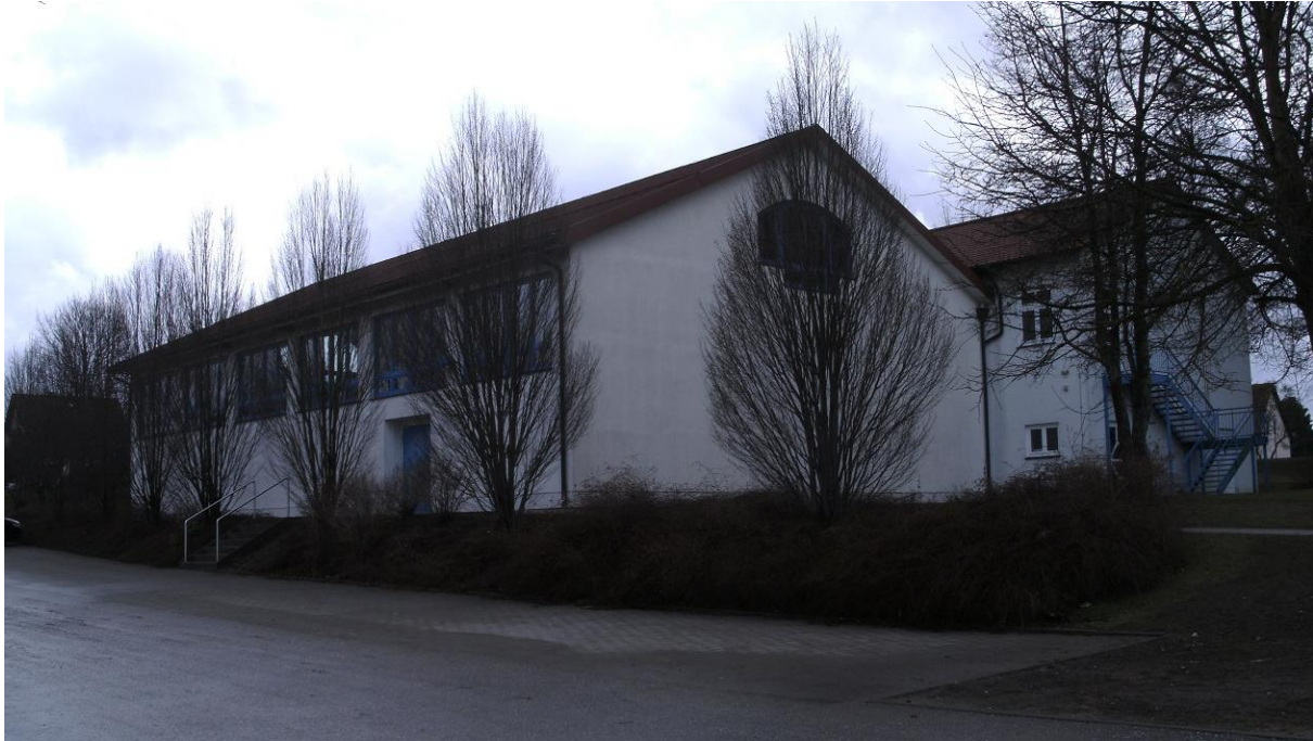
Mehrzweckhalle Stulln - Ansicht von Dammweg -
