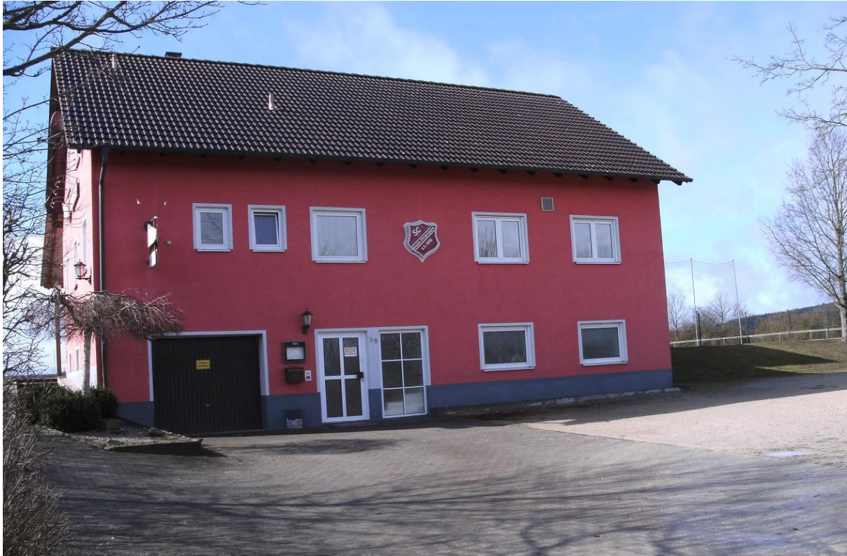
Sportheim SC Kreith - Pittersberg 1968 - Ansicht von Kreither Straße -
